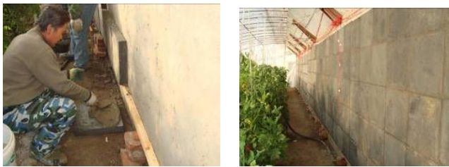
图 2 2#相变温室施工现场图
